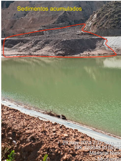
Figura 111. Vista de los sedimentos acumulados en la poza 2000-PC-07
