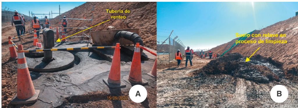
Figura 84. Vista de la tubería de venteo de la línea de conducción de concentrado hacia la poza de remolienda, desde donde ocurrió el derrame (a) y Vista del suelo con relave apilado luego de las actividades de limpieza del derrame (b). Nota. Tomado de OEFA (2022d, p. 12)
