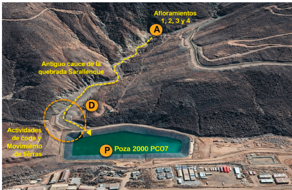
Figura 103. Representa la ubicación de las filtraciones identificadas durante la acción de supervisión setiembre 2019. 48 Nota. Tomado de OEFA (2020c, p. 10)
