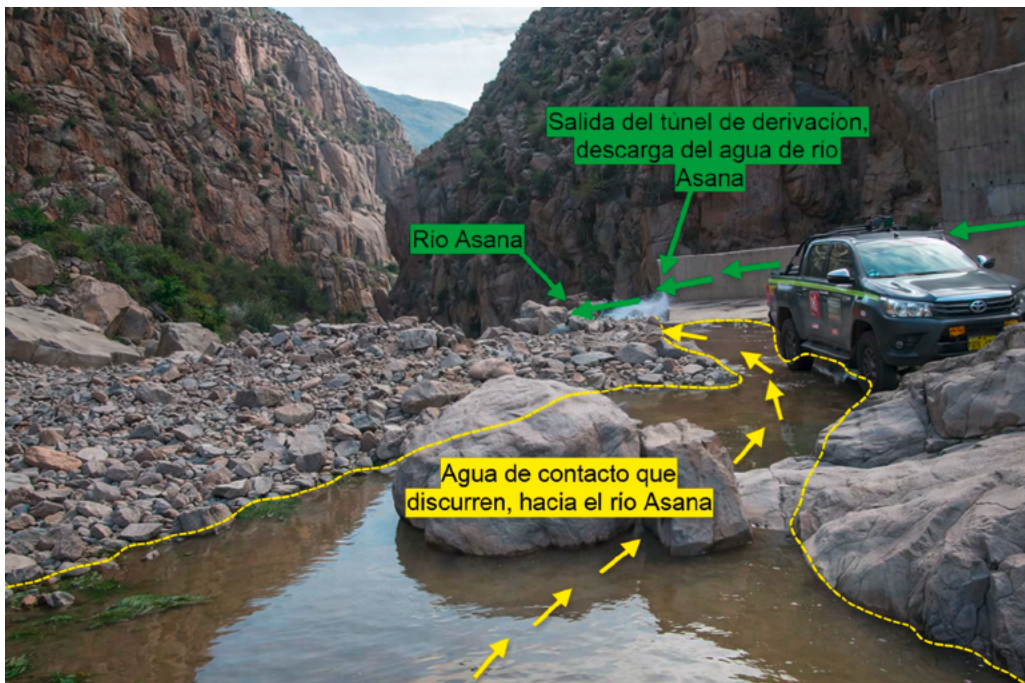
Figura 104. Se observa que el agua de contacto genera un empozamiento y discurre hacia el río Asana, se observa la inexistencia de estructuras para la captación de aguas de contacto. Líneas de color verde (---): Representa al agua del río Asana que sale del túnel de derivación. Líneas de color amarillo (---): Representa al agua de contacto que discurre hacia el río Asana.
