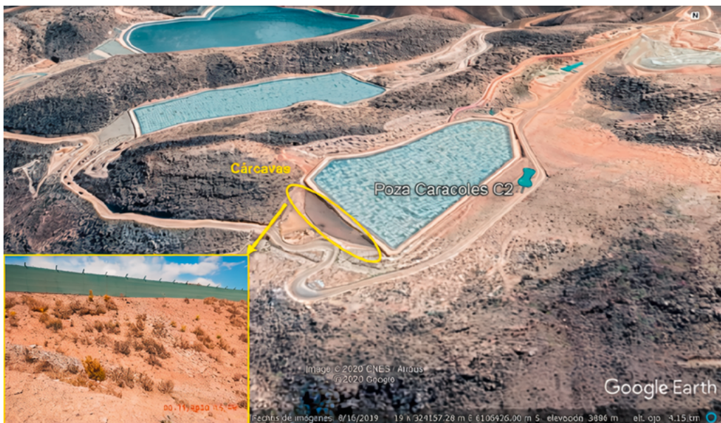
Figura 113. Imagen satelital en la que se señala la ubicación de la poza Caracoles C-2 y de las cárcavas observadas durante la supervisión.
