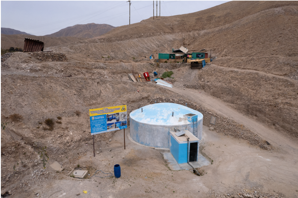
Figura 155. Reservorio de agua en el distrito de Samegua Fuente: El Foco
