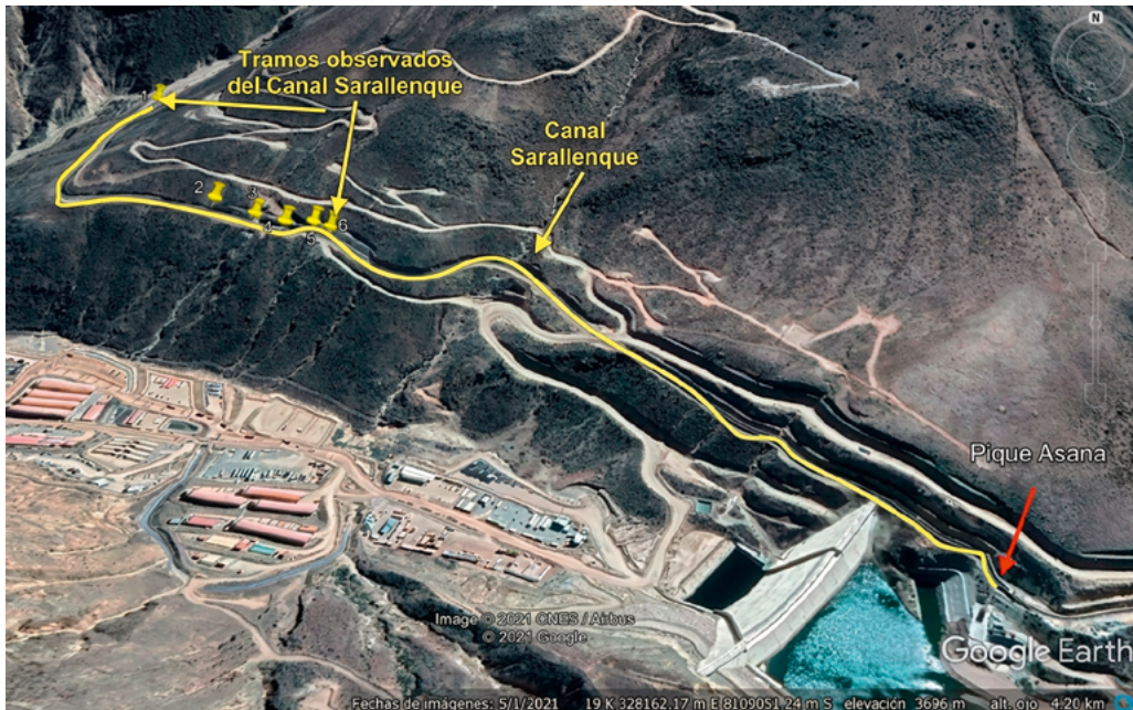
Figura 80. Imagen satelital de los tramos verificados del canal Sarallénque, en el cual se observó acumulación de sedimentos, así como deslizamiento de material del talud adyacente. Nota. Tomado de OEFA (2021d, p. 5)
