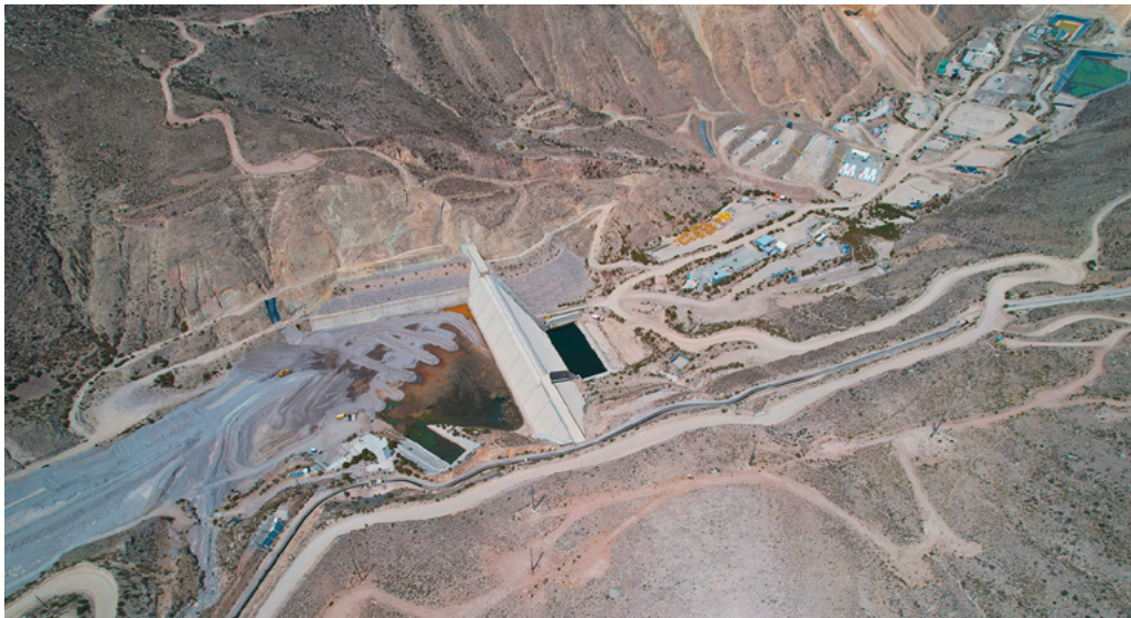
Figura 33. Fotografía panorámica de dique y túnel de derivación del río Asana. Fuente: Red Muqui
