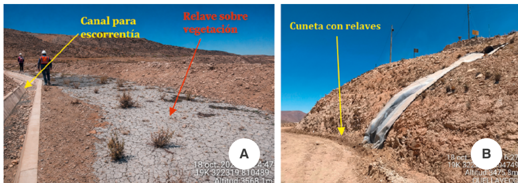
Figura 85. Vista del suelo con relave sobre vegetación y canal de escorrentías por donde discurrió el derrame (a) y Vista canal de escorrentías con geomembrana donde convergen las cunetas del acceso "Quellaveco" por donde discurrió el derrame hacia la poza 2000-PC- 002 (b)
