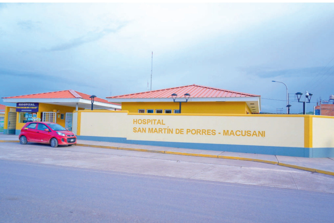
Figura 35. Hospital San Martín de Porres de Macusani.
